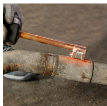
Demontarea țevilor de eșapament
