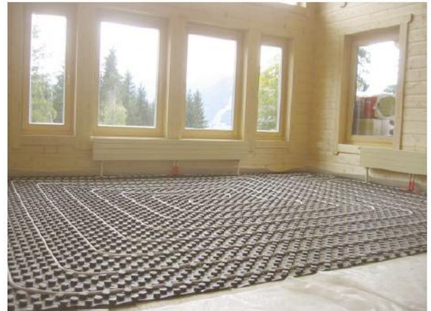
Încălzire prin pardoseală cu elemente de construcție cu plăci cu nuturi
