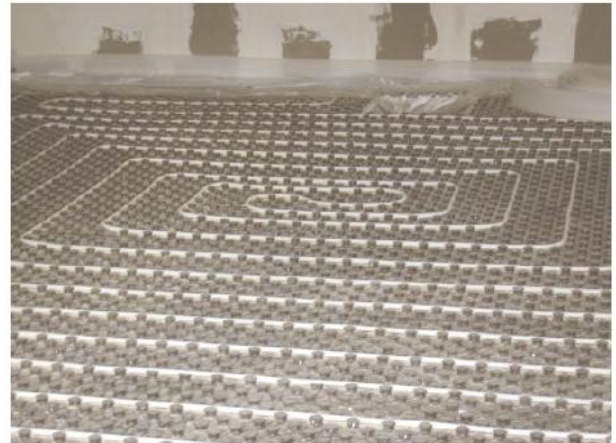
Reglarea în sistem melc cu plăci cu nuturi
