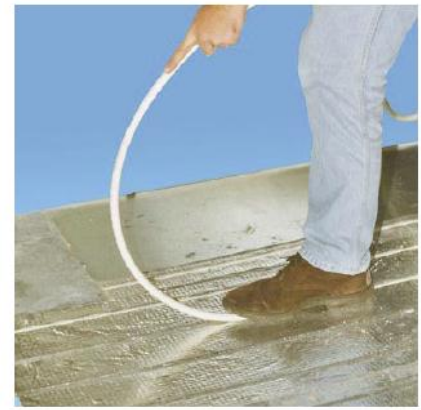
Introducerea prin apăsare a țevilor de încălzire
