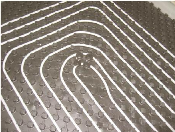
Încălzire prin pardoseală cu elemente de construcție cu plăci cu nuturi
