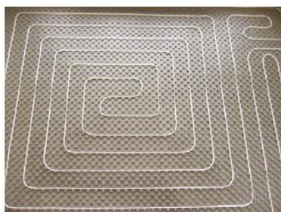
Punere în operă bifilară cu plăci cu nuturi
