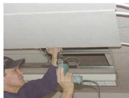
Montaj sistem de răcire prin tavan
