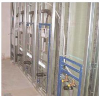
Exemplu: Instalații în peretele intermediar în domeniul sanitar cu țevi HERZ
