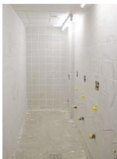
Exemplu: Instalații în peretele intermediar în domeniul sanitar cu țevi HERZ
