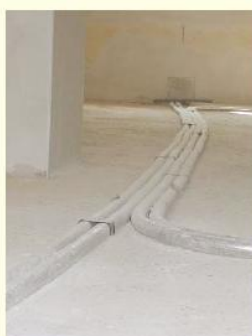
Exemplu: Conectarea distribuitorului HERZ pentru montajul sub tencuială
