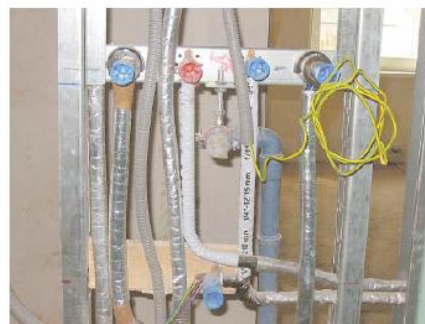
Exemplu: Instalații în peretele intermediar în domeniul sanitar cu țevi HERZ
