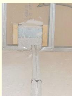
Exemplu: Conectarea distribuitorului HERZ pentru montajul sub tencuială
