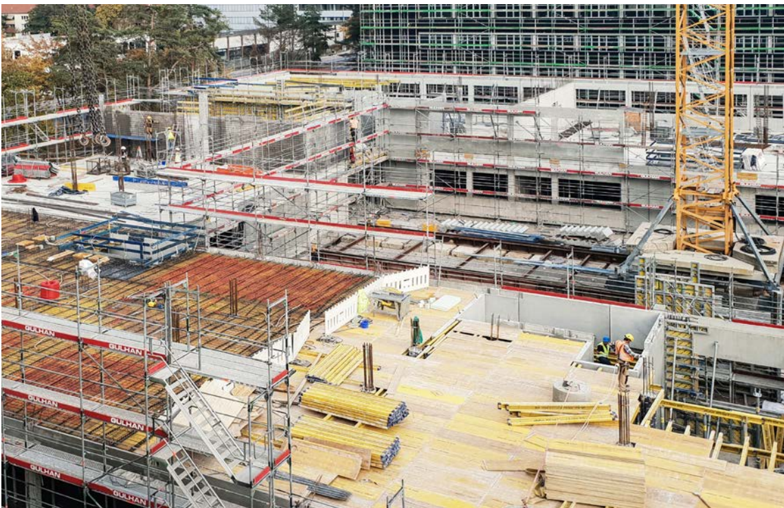
Campus Erlangen Temperare miez beton 44.000 m 2
