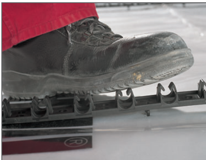
Fig. 3-39 Șinele REHAU-RAUFIX se vor apăsa în podea.
