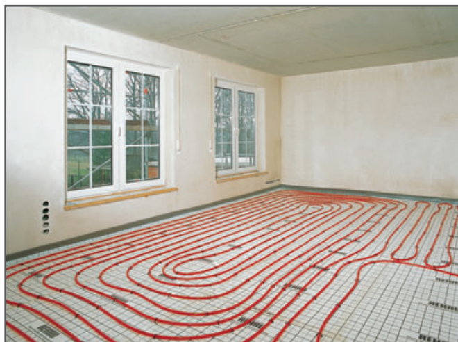
Fig. 3-27 Sistemul REHAU cu placă tacker
