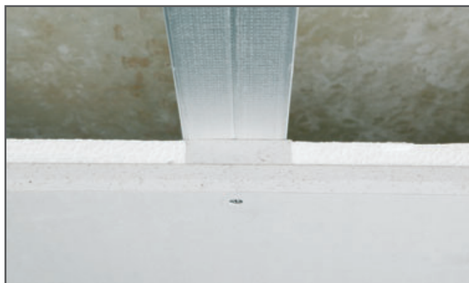
Fig. 4-6 Elemente de prindere în tavan montate
