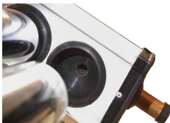
(5) introduceți și rotiți tuburile solare în colectorul de căldură
