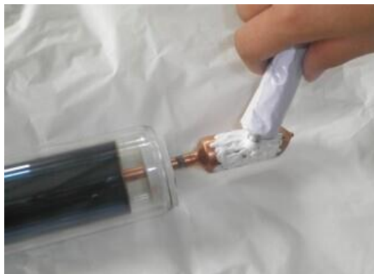
(3) Acoperiți cu pastă termică de contact suprafața de condensare
