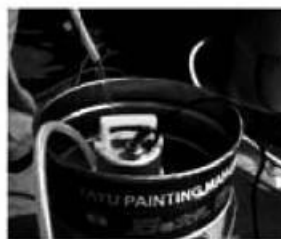
pompa submersibilă se scufundă în antigel pentru umplerea instalației
