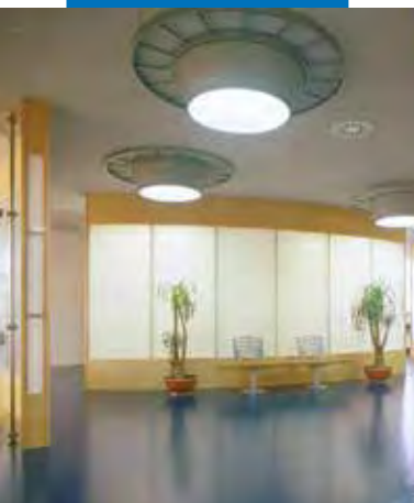
Exemplu de montaj pardosela din dale de cauciuc utilizand Ultrabond Eco Fix - IBM Centre - Spania
