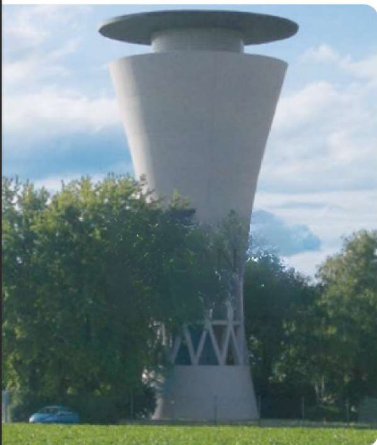
Turn de apă pentru depozitarea apei potabile
