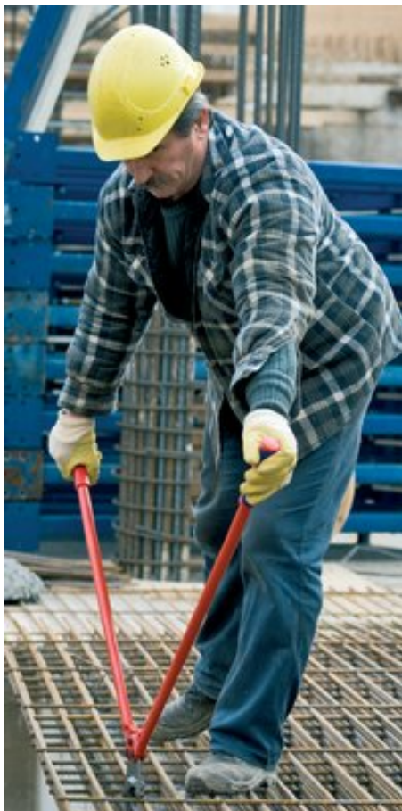
Forma specială a capului cle#telui de tăiat plasa de armătură 71 82 950 permite tăierea o#elului pentru construc#ii Întins pe jos
