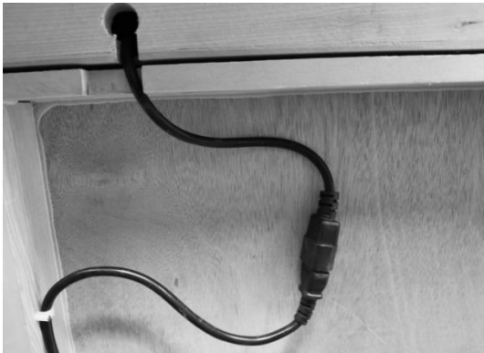
(1) Conectați conectorii cablurilor de încălzire, (2) Conectați conectorul cablurilor de comandă.
