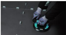
3.6 O singură ventuză de vid de 8" poate ridica max. 120K (6" pentru ridicarea a 100 kg)
