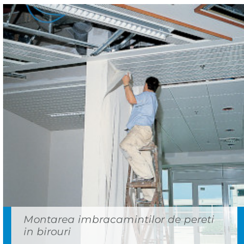
Montarea fasciilor de îmbracaminti de pereti cu Adesilex MT32
