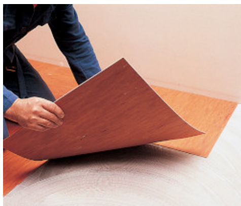
Montarea dalelor din PVC omogen cu Adesilex V4
