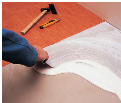
Intinderea Adesilex V4 pentru instalarea dale din PVC omogen
