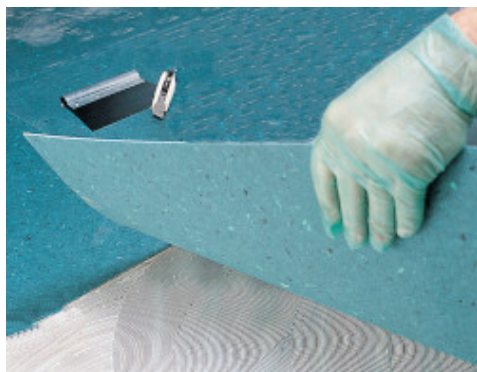
Montarea dalelor din PVC omogen cu Adesilex V4, lipite pe doua fete alaturate
