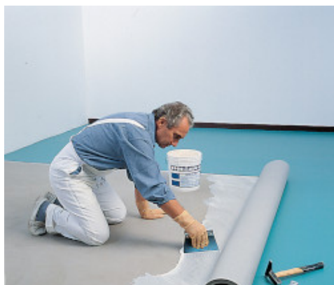
Role de PVC omogen motate cu ADESILEX V4
