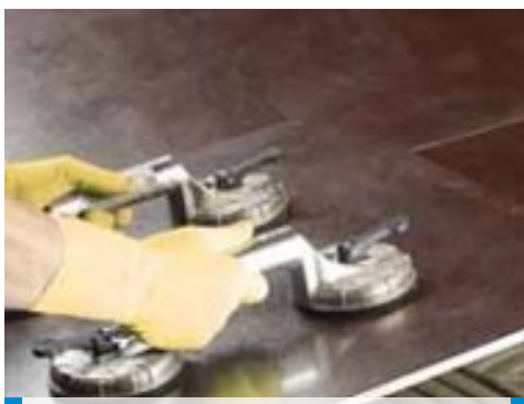
Aplicarea plăcilor de gresie portelanată de mari dimensiuni cu adezivul Kerabond T-R în amestec cu Isolastic
