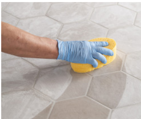
Curățarea și finisarea rosturilor cu un burete din celuloză dură
