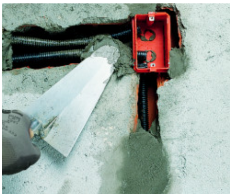
Fixarea dozelor si traseelor pentru cabluri electrice utilizand Lampocem
