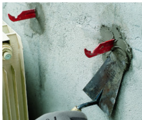
Fixarea consolelor pentru radiatoare utilizand Lampocem
