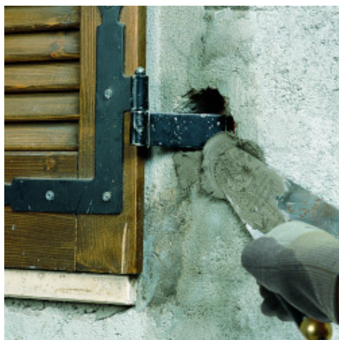
Fixarea consolelor pentru ferestre utilizand Lampocem
