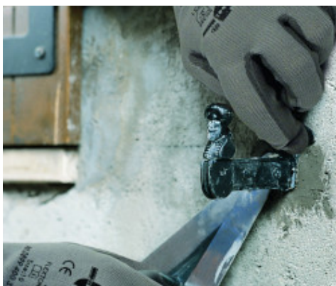
Fixarea consolelor pentru ferestre utilizand Lampocem
