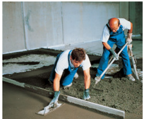
Repararea rapida a unei sape intr-un supermarket
