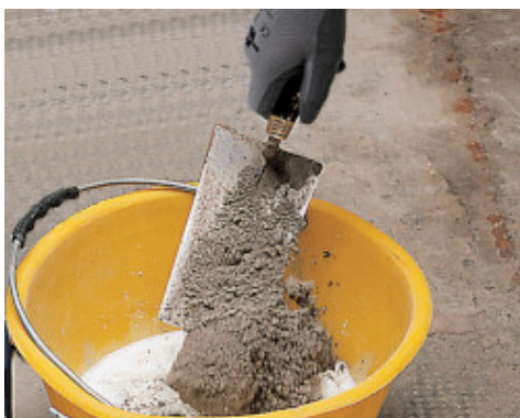
Amestecarea Mapecem cu Planicrete pentru a obtine o amorsa (suspensie) de aderenta
