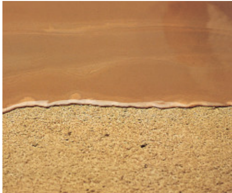
Finisarea unei sape Mapecem cu sapa autonivelanta Ultraplan
