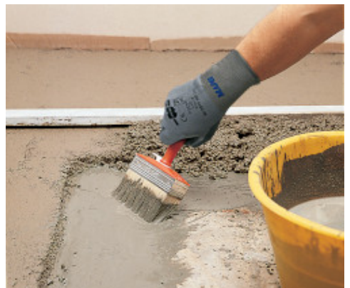
Aplicarea amorsei de aderenta pentru sapele aderente Mapecem
