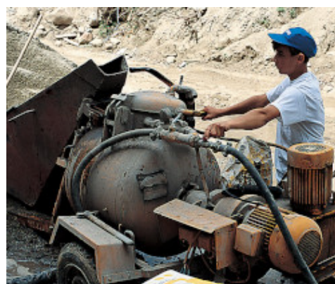
Amestecarea Mapecem cu o unitate de pompare automată
