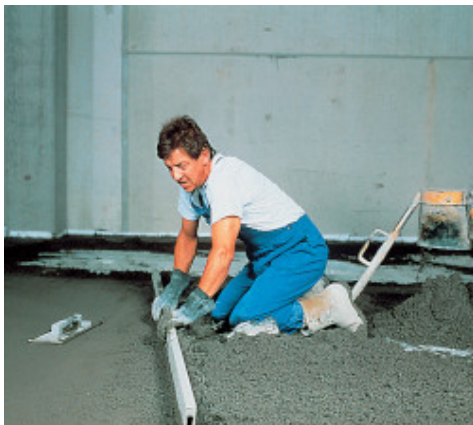
Utilizarea unui dreptar
