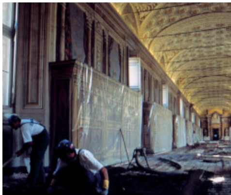
Aplicarea si nivelarea sapei Mapecem - Capela Sixtina - Vatican
