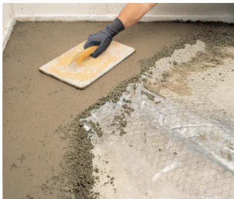
Acoperirea conductelor cu Mapecem si plasa de armare
