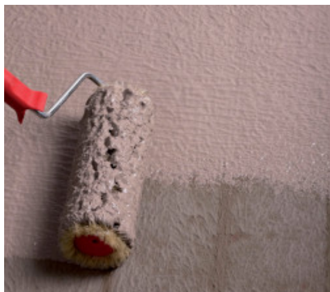
Hidroizolarea unei terase cu trafaletul
