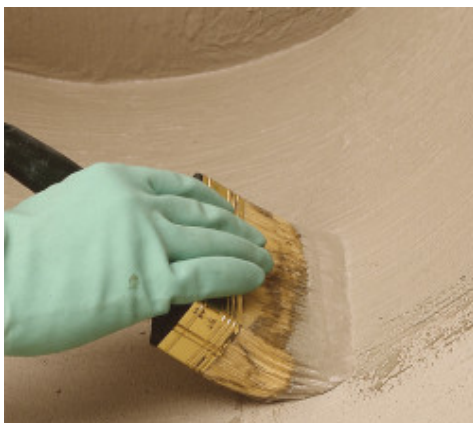
Hidroizolarea detaliilor cu pensula
