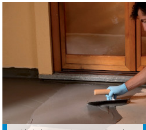
Hidroizolarea unei terase aplicand materialul cu fierul de glet
