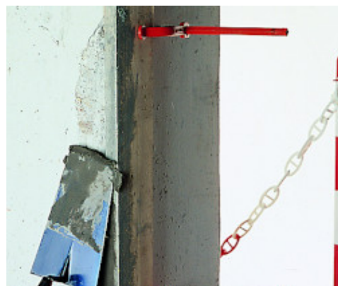
Repararea unei margini verticale cu Nivorapid
