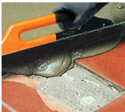
Astuparea gaurilor cu Nivorapid
