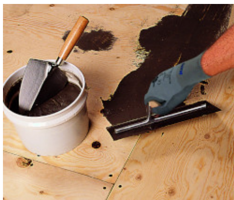
Chituirea unui suport din placaj cu Nivorapid + Latex Plus
