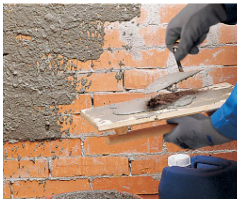
Aplicarea spritului adeziv aditivat cu Planicrete
