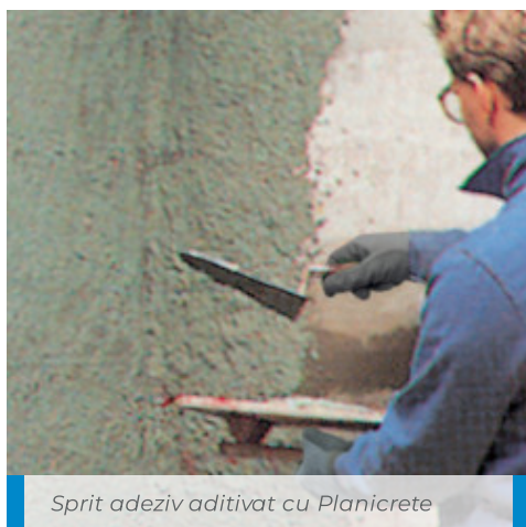
Aplicarea amorsei de aderenta pe baza de ciment aditivata cu Planicrete
