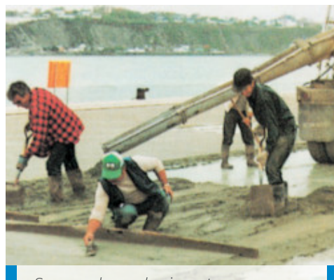
Sapa pe baza de ciment cu Planicrete aplicata - Vieux Port, Quebec, Canada
