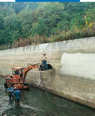
Planiseal 88 aplicat prin pulverizare într-un canal hidroelectric
