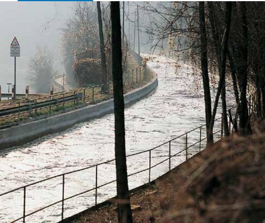
Canalul hidroelectric Bertini - Como, Italia. Suprafața a fost tratată cu Planiseal 88
