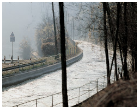
Canalul hidroelectric Bertini - Como - Italia. Suprafete tratate cu Planiseal 88
