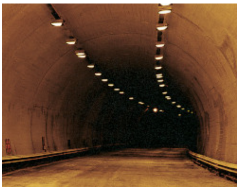
Aplicarea de Planiseal 88 alb prin pulverizare într-un tunel de autostrada
