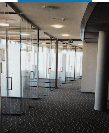
Montaj mocheta în Centul Postal utilizând Ultrabond Eco Fix - Post Tower - Italia
