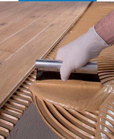
Aplicarea Ultrabond P990 1K
