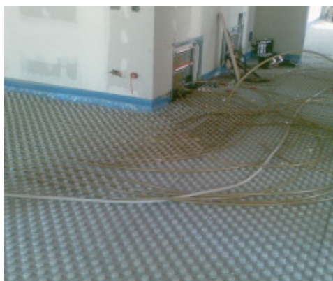
Pregătirea sistemului de încălzire/răcire în pardoseala
