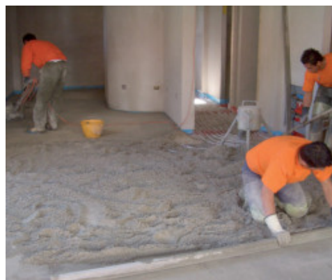
Aplicarea amestecului aditivat cu Mapescreed 704
