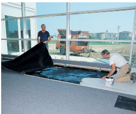
Montarea unei pardoseli industriale intr-o companie de electronice
