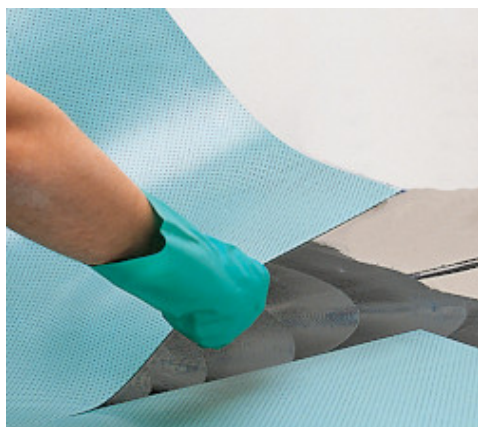
Montarea placilor conductive din PVC
