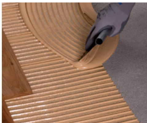
Montare de parchet masiv pe sapa Topcem
