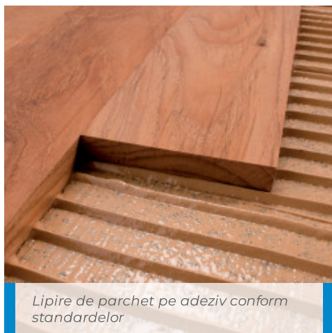
Montare de parchet masiv pe sapa Topcem
