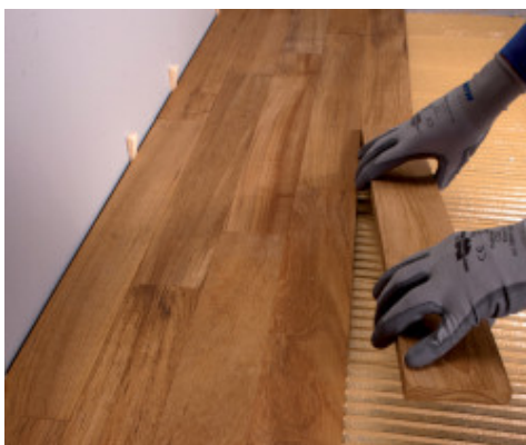
Montare de parchet cu dimensiune mare
