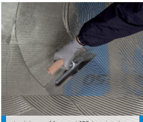
Inglobarea Mapenet 150 in primul strat de Mapelastic Turbo cat este inca proaspat
