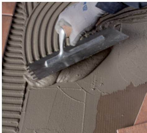
Lipirea placilor cu Elastorapid
