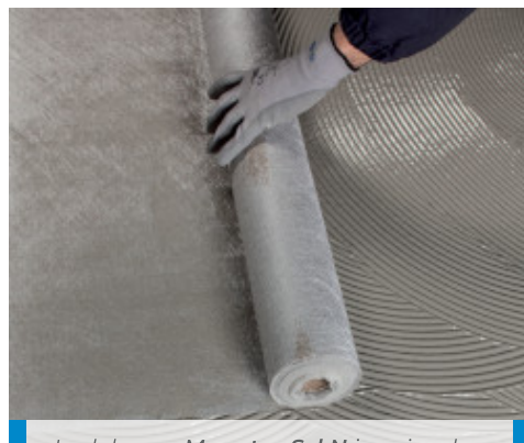
Inglobarea Mapetex Sel N in primul strat de Mapelastic Turbo cat este inca umed
