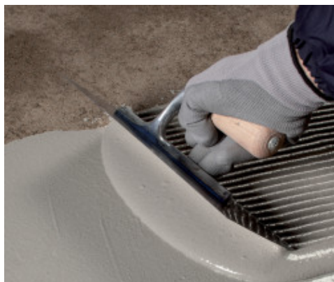
Aplicarea primului strat de Mapelastic Turbo
