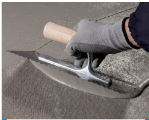
Aplicarea celui de-al doilea strat de Mapelastich Turbo peste primul strat armat cu Mapetex Sel N
