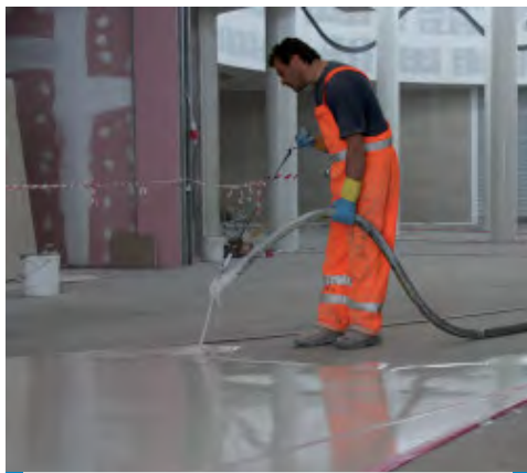
Aplicarea mecanizata a Ultratop
