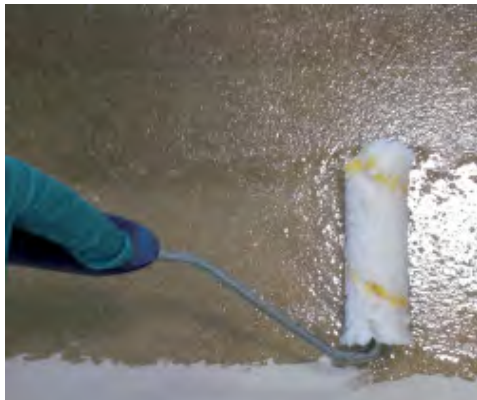
Efectul "Terrazzo alla veneziana". Aplicarea de Mapecrete I 910
