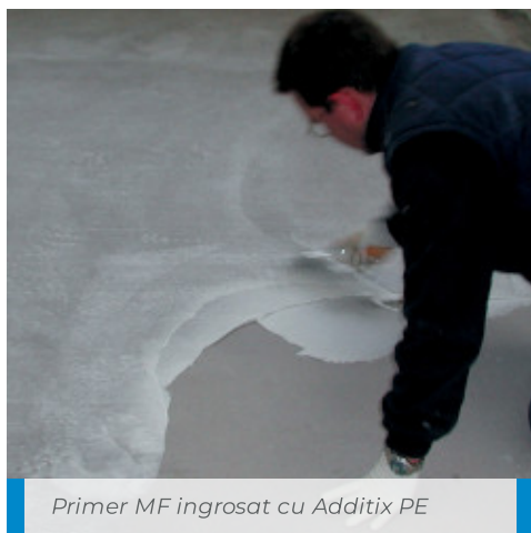
Chituirea unui rost cu Primer MF amestecat cu Additix PE
