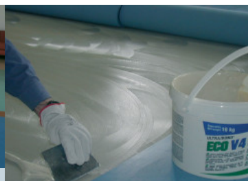
Aplicarea Ultrabond Eco V4SP - Sanatoriul San Martino - Italia
