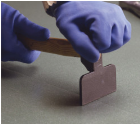
Presarea imbinarilor dintre fasii
