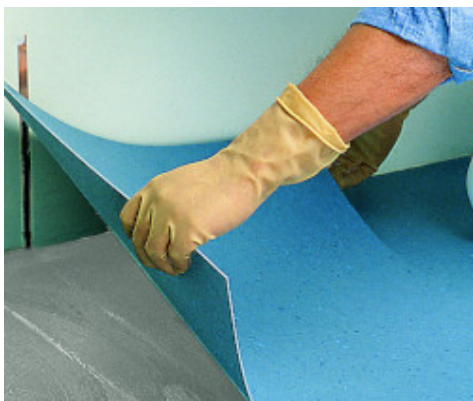
Montarea placilor din PVC conductiv cu Ultrabond Eco V4 SP Conductiv
