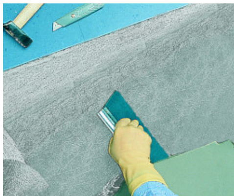
Aplicarea Ultrabond Eco V4 SP Conductiv
