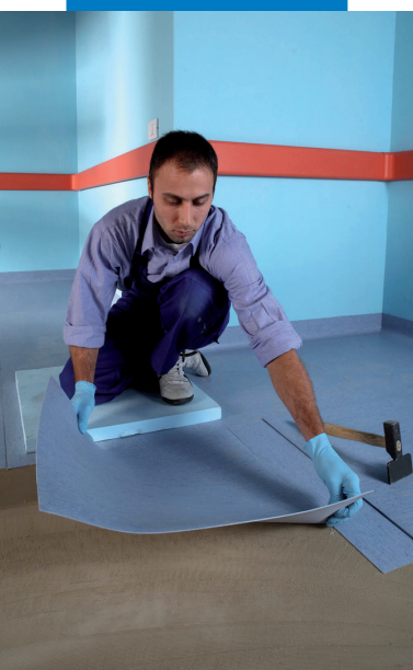
Montarea dalelor din PVC
