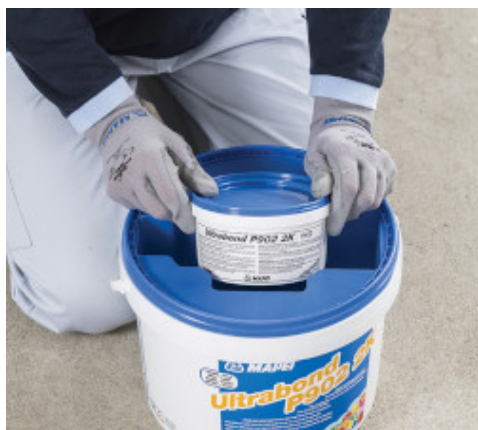
Extragerea componentei B din capac
