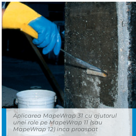
Presarea tesaturii cu ajutorul Rolei pentru MapeWrap, astfel incat MapeWrap 31 sa poata patrunde bine in tesatura.
