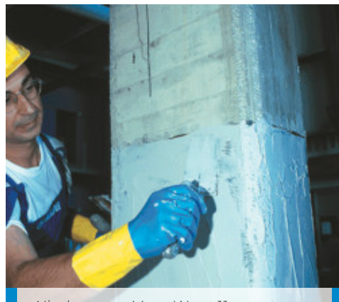
Nivelarea cu MapeWrap 11 sau MapeWrap 12
