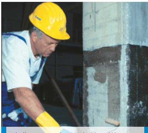
Aplicarea unui strat de MapeWrap Primer 1
