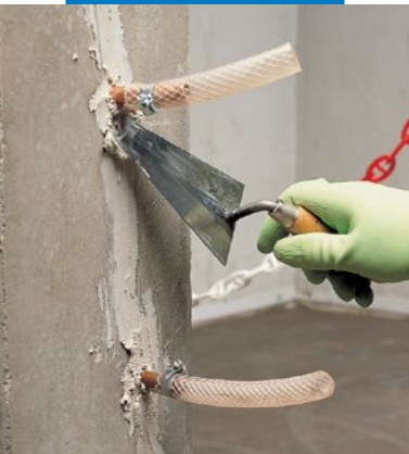
Fixarea tuburilor de injectare și sigilarea fisurilor la consolidarea structurală
