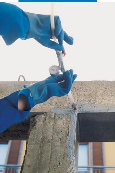
Grindă placată cu Adesilex PG1
