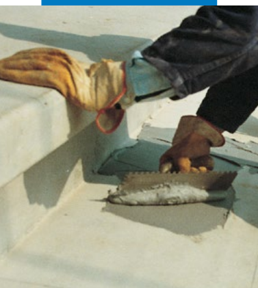
Aplicarea Adesilex PG1 cu o spatulă dințată la lipirea structurală a treptelor prefabricate
