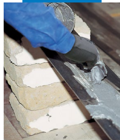
Aplicarea Adesilex PG1 pe o platbandă metalică
