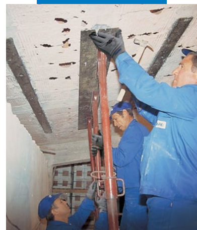
Aplicarea platbandei metalice pentru armarea structurală
