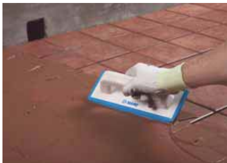
11. Dupa aplicarea produsului hidroizolator MAPEI conform Fisei Tehnice, montati imbracamintea de pardoseala si chituiti rosturile
