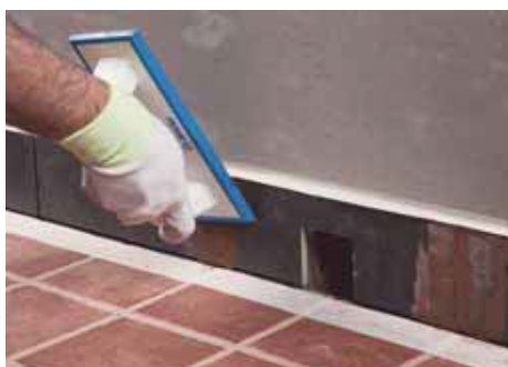
12. Montati plintele si chituiti rosturile verticale
