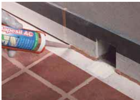
13. Etansati cu Mapefil AC rosturile corespunzatoare plintelor
