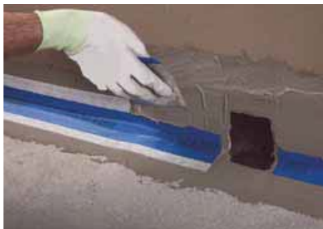
8. Aplicati Mapeband presandu-l de-a lungul muchiilor, asigurandu-va ca nu mai exista cute sau bule de aer
