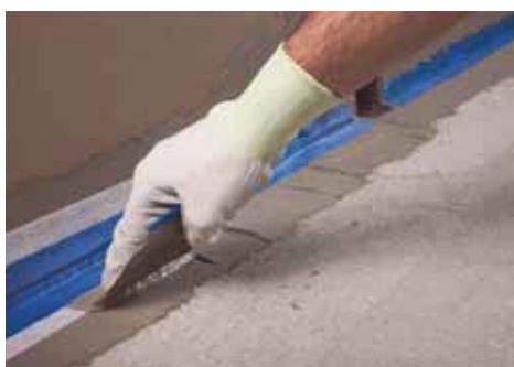
9. Aplicati un al doilea strat de produs hidroizolator MAPEI pentru a acoperi complet marginile benzii astfel incat acestea sa fie complet inglobate in mortarul pe baza de ciment
