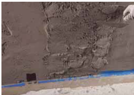
10. Aplicati un strat nou de tencuiala pe parapet, sau, reparati tencuiala veche in cazul structurilor vechi
