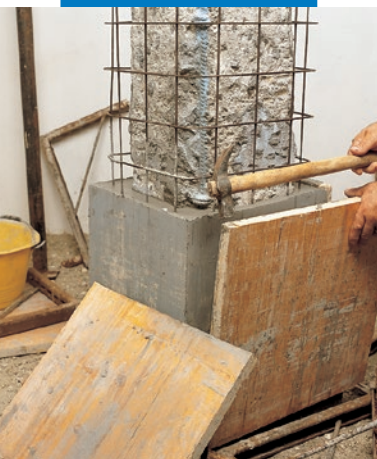
Îndepărtarea cofrajelor de lemn
