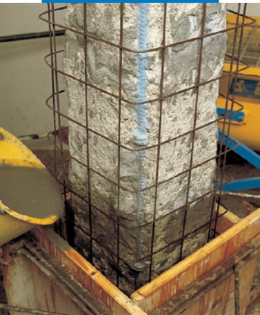
Turnând într-un cofraj
