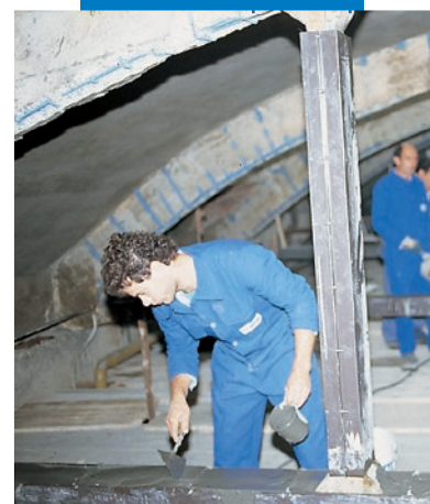
Turnând Mapegrout Hi-Flow în cofraje metalice
