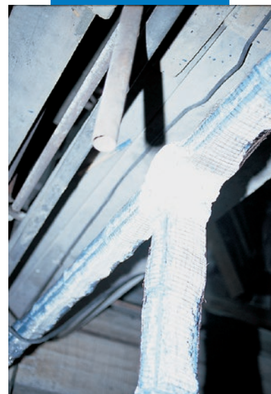
Structură de beton deteriorată
