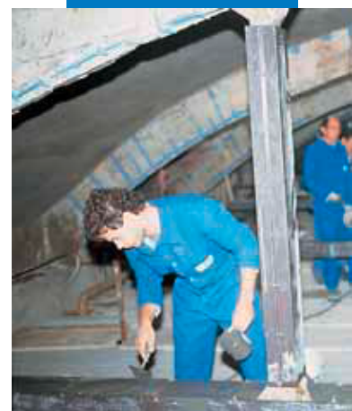
Mapegrout Hi-Flow turnat într-un cofraj metalic
