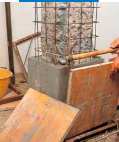
Îndepărtarea cofrajului din lemn
