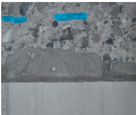
Mapegrout Colabile GF dupa inlaturarea cofrajului
