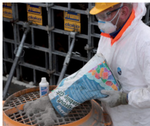
Pregatirea Mapegrout Colabile GF cu un adaos de Mapepure SRA
