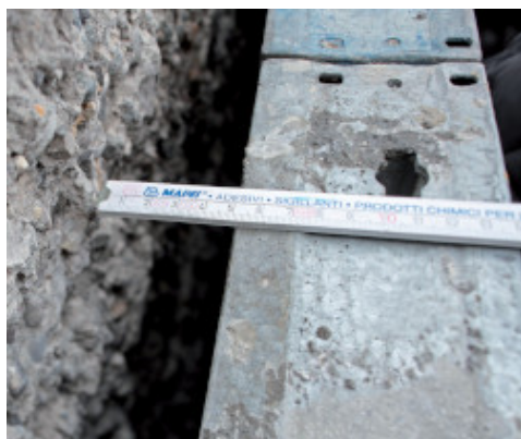
Pozitionarea cofrajului etans dupa ce acesta a fost pregatit cu grija
