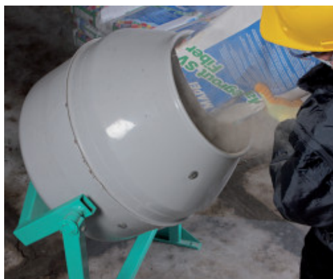
Pregatirea amestecului Mapegrout SV Fiber
