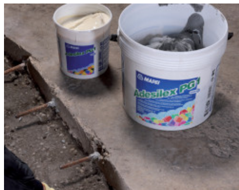
Fixarea tijelor de armare pentru dibluri cu ajutorul Adesilex PG1
