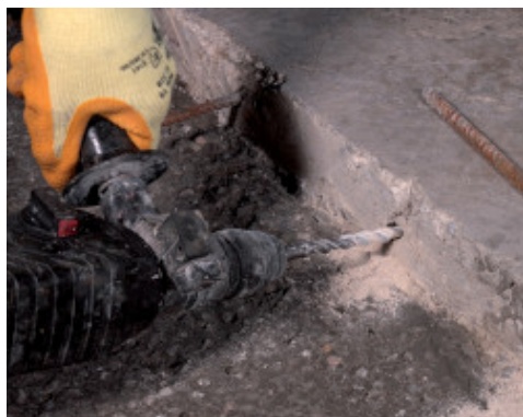
Pregatirea gaurilor pentru introducerea tijelor de armare (dibluri)
