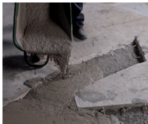
Aplicarea de Mapegrout SV Fiber în zona de reparatii
