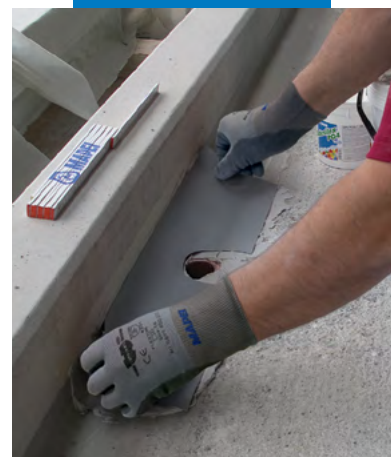
Poziționare profil flexibil din hyphalon
