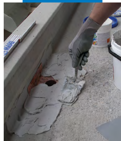
Finisare ulterioară cu Adesilex PG4
