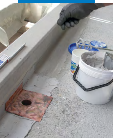
Positionarea unei flanșe din cupru cu umăr și a unei țevi de scurgere
