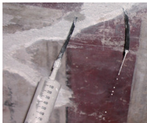
Injectarea de Mape-Antique F21 intr-un perete cu fresca
