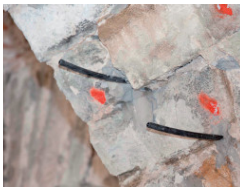
Vedere detaliata a modului in care tuburile de injectie sunt fixate in pozitie
