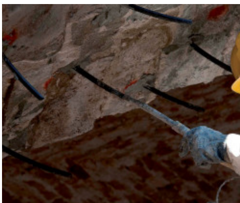
Injectarea de Mape-Antique F21 intr-o zidarie de piatra
