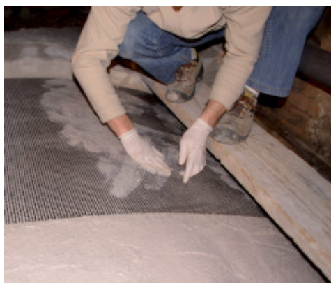
Pozitionarea Mapegrid B 250
