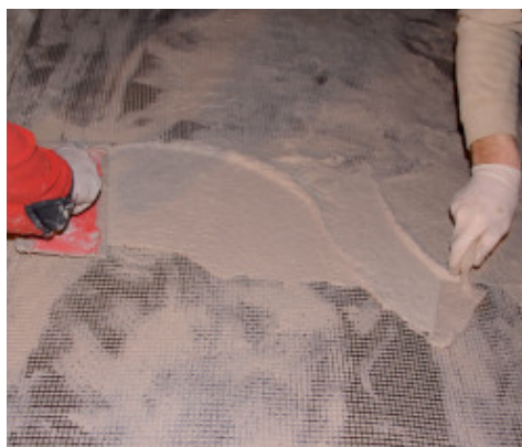
Aplicarea celui de-al doilea strat de Planitop HDM Restauro
