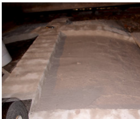
Aplicarea primului strat de Planitop HDM Restauro
