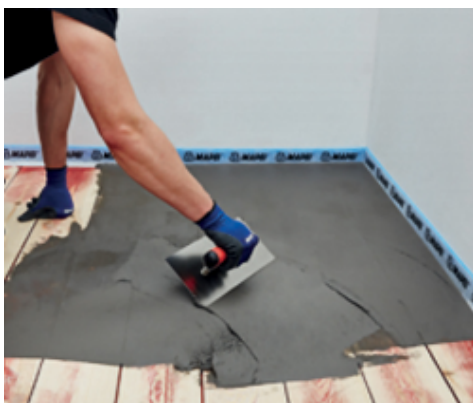
Aplicarea Planipatch Xtra + Latex Plus pe un suport din lemn
