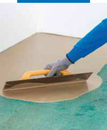
Aplicarea de sapa autonivelanta peste Mapeproof Primer
