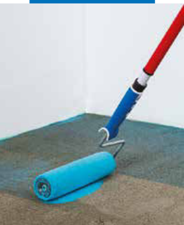
Aplicarea primului strat de Mapeproof Primer
