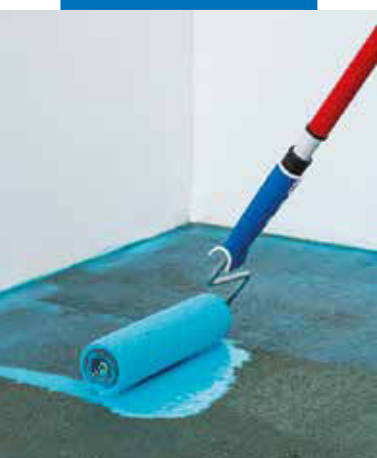
Aplicarea celui de-al doilea strat de Mapeproof Primer
