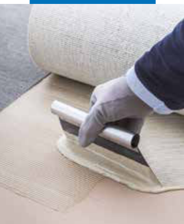
Montarea mochetei cu dos Action Back®
