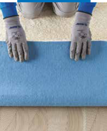
Montarea mochetei cu dos din pasla
