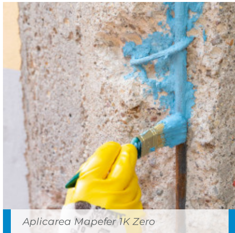
Aplicarea Mapefer 1K Zero pe barele de armatură la un viaduct
