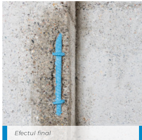
Aplicarea Mapefer 1K Zero pe barele de armatură la un viaduct
