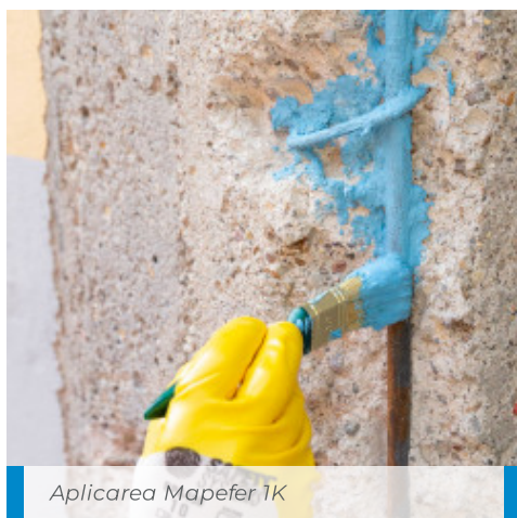
Aplicarea Mapefer 1K pe barele de armatura la un viaduct
